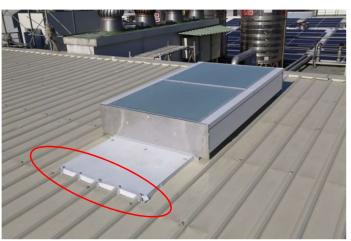
11. 依浪板需求修剪側封板,在採光通風天窗兩邊側邊置放側封板, 並鎖上螺絲,以矽利康填縫
