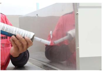
12. 放置軟墊片於玻璃框架後,置放5mm+5mm強化白膜膠合玻璃於採 光通風天窗上,並貼上矽利康遮蔽膠帶始施打矽利康
