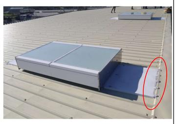
10. 置放下邊水切:水切長度為30公分,水切內部成80度折起,並依浪板凸凹溝位置做修剪,鎖上螺絲,並以矽利康填縫
