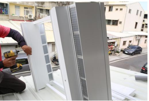
1. 依序放上採光通風天窗,兩樘續接處以左右各鎖1支螺 絲,加強兩樘密接
